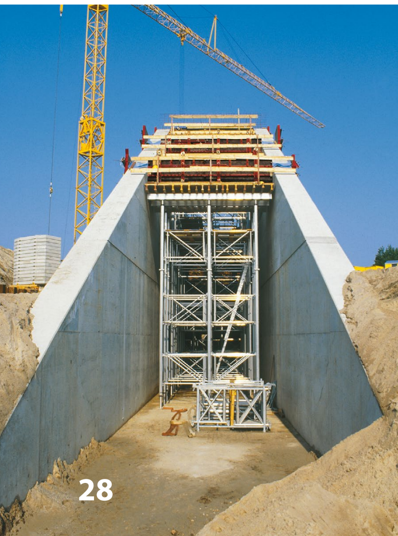
Einlaufbauwerk Lohsa II
