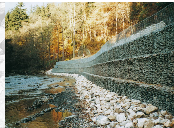
Gabionenwand: naturnahe Stützwall als Böschungssicherung an der Bode bei Altenbrak
