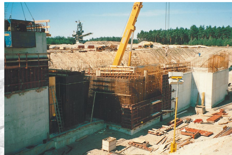
Einlaufbauwerk Bewehrungsarbeiten
