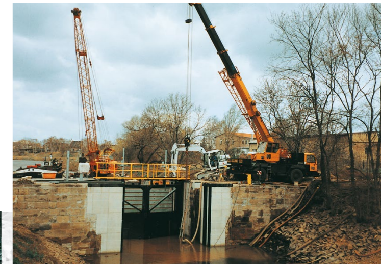
Sanierung Fangschleuse Halle-Trotha
