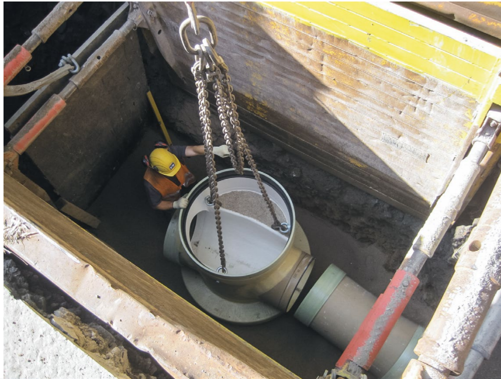
Schachtbaugrube GFK DN 600 Clausthal-Zellerfeld
