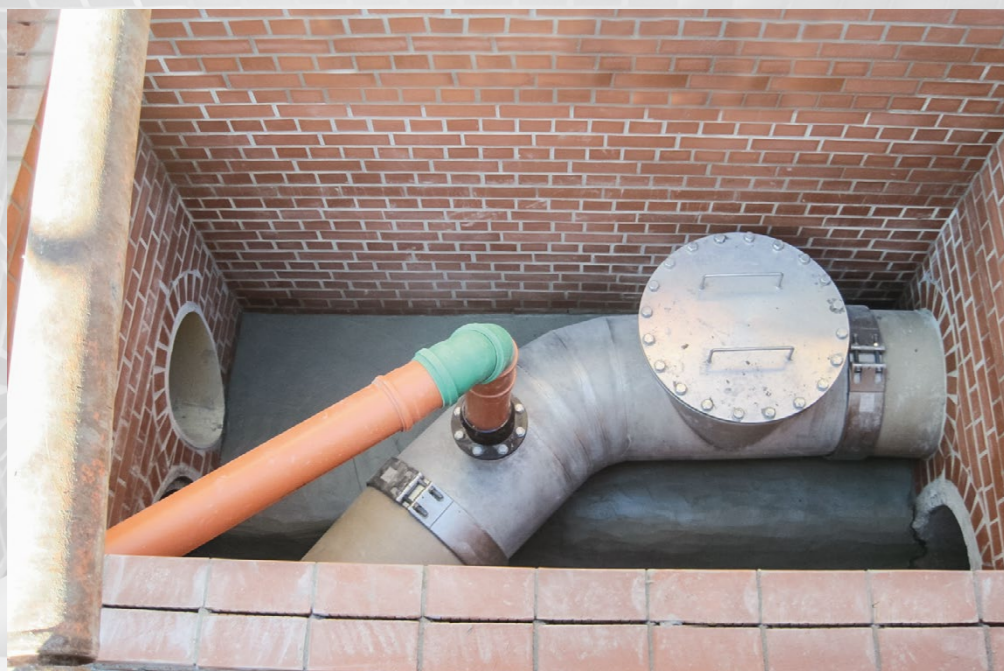
Schachtneubau mit verschlossenen Kanal mit offener Rinne Clausthal-Zellerfeld
