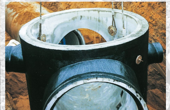
Kanalbau Schkeuditz DN 2000
