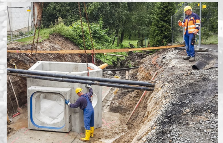
Steinzeugrohrleitung DN 400 in Halle (Saale)
