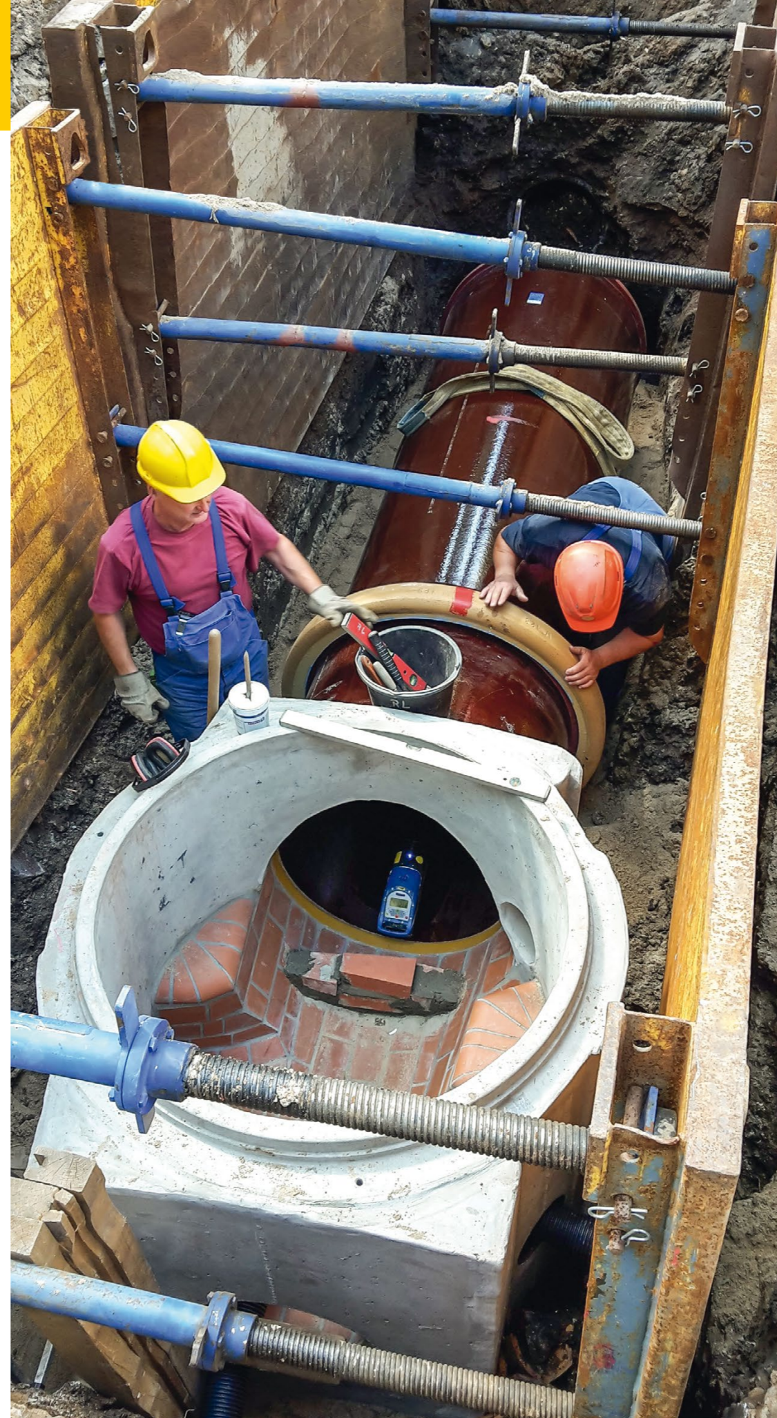
Mischwasserhauptsammler Leipzig - Leutzsch
