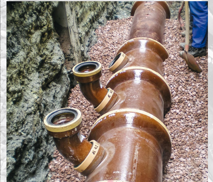
Steinzeugrohrleitung DN 400 in Halle (Saale)
